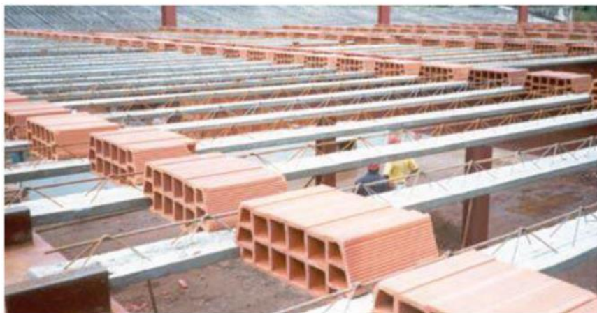
Montagem simples e rápida com pré-lajes de 1,25 m sob blocos de EPS (Condomínio Residencial em Campinas).
